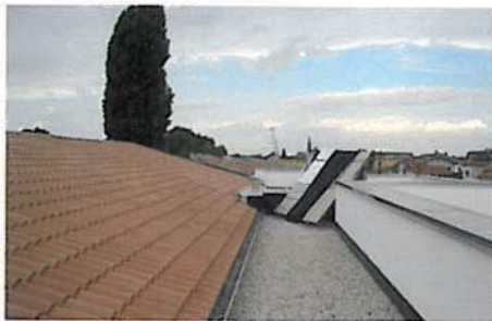
Vista della copertura ultimata
